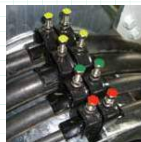
ケーブルクランプ取付状態 (CR-Wタイプ)
