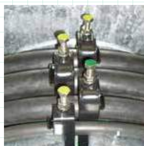
ケーブルクランプ取付状態 (CR-1タイプ)
