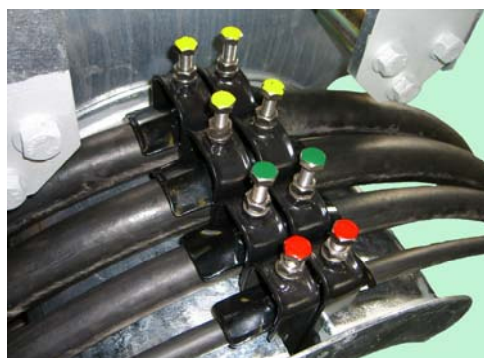
ケーブルクランプ取付状態 (CR-Wタイプ)
